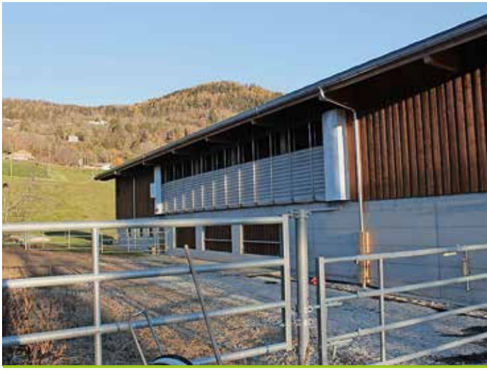
La courette a été recouverte d'une grille de sol durable Eco-raster. La façade nord est dotée d'un rideau gonflable transparent Lumitherm qui assure lumière, ventilation et isolation.
